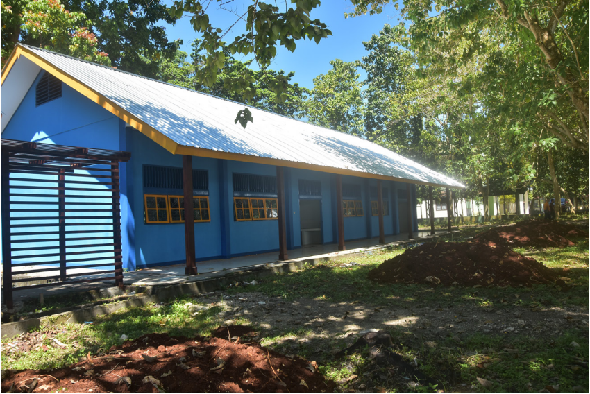
Bangunan eks BLK Manokwari yang akan digunakan sebagai ruang kelas
