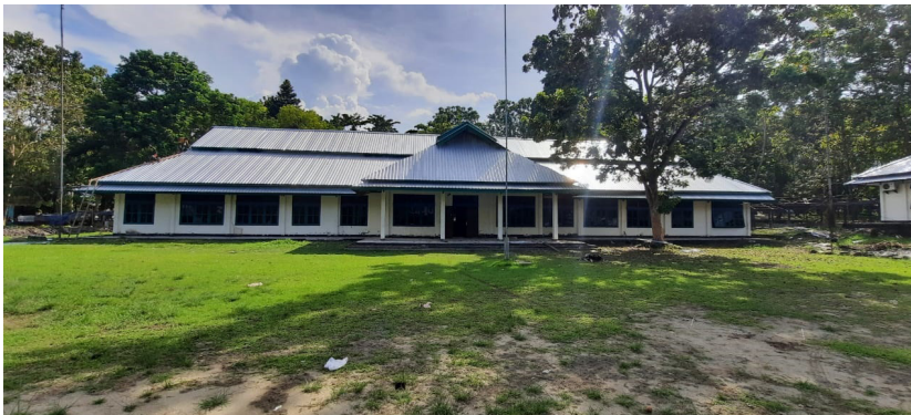
Salah satu bangunan bekas BLK Manokwari yang kemudian akan digunakan sebagai Kantor SMA Taruna Kasuari Nusantara Provinsi Papua Barat
