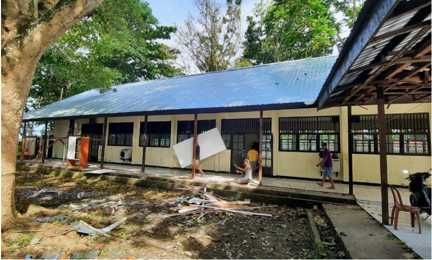
Bangunan gedung eks. BLK Manokwari sedang direnovasi
